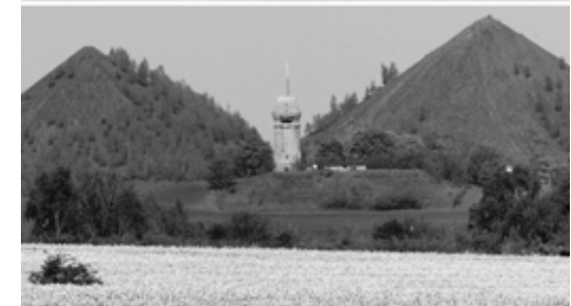
Wismut-Halden nahe Reust bei Ronneburg. Landschaft 2004 und 2006, nach dem Abtragen von 3,6 Mio. m³ Haldenmaterial
